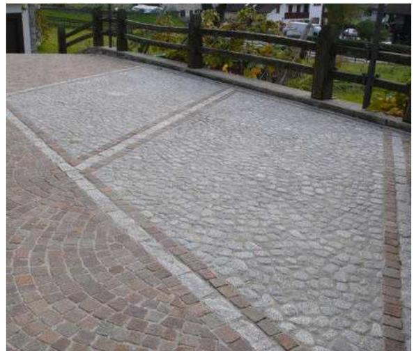
Classica pavimentazione in cubetti di porfido a coda di pavone con colorazione mista a fuga aperta
